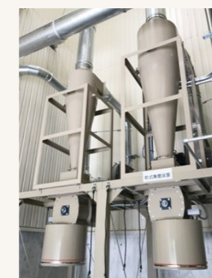
ダスト回収装置 (サイクロン方式 or バグフィルター方式)
