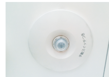
▶ 人感センサー 人の出入りを感知して最適な吸引量にて運転します
